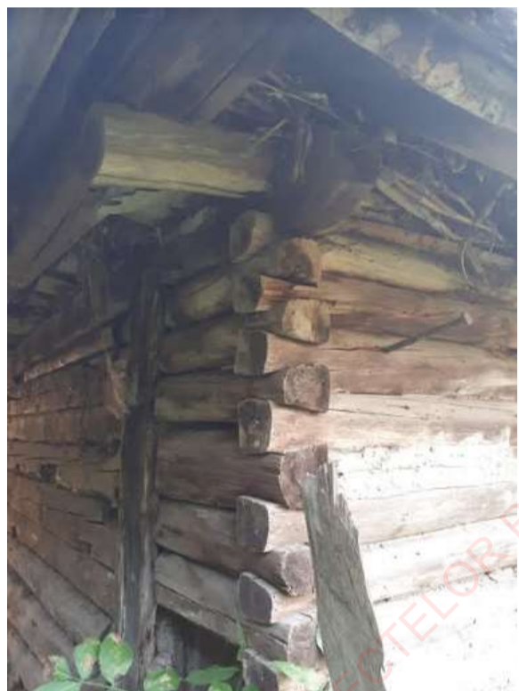
9. Ferești, Maramureș: Bârne de lemn în construirea casei tradiționale maramureșene. (foto: I. M. Farcaș)
