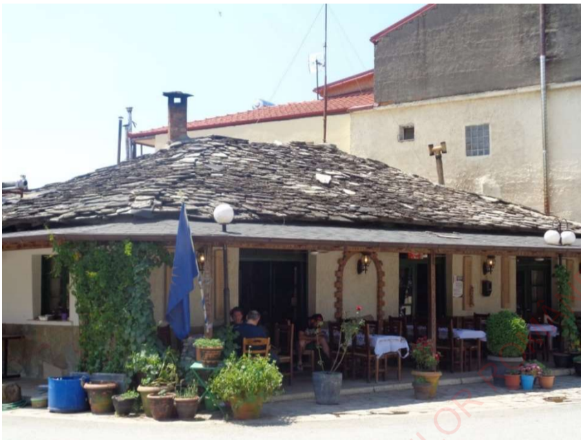
154. Grecia, Oșiini (Arhanghelos), Taverna veche funcționează într-o clădire veche care păstrează arhitectura tradițională a zonei cu acoperișul făcut din pietre de râu. (foto: M. Nevaci; I. Floarea)
