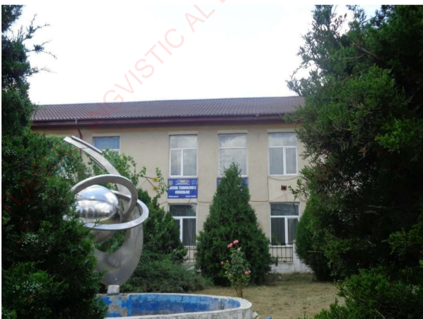
54. România, Cogealac (jud. Constanța): Liceul Tehnologic din Cogealac. (foto: M. Nevaci; I. Floarea)
